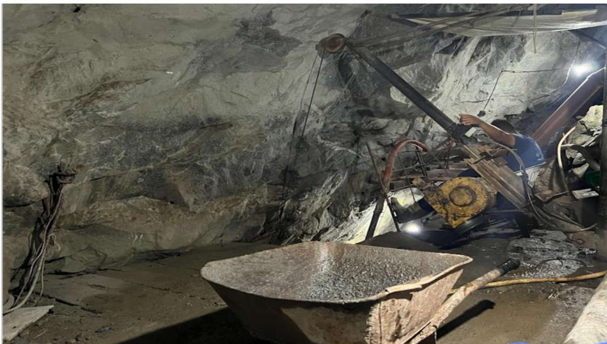
Figura 45. Guincho com motor elétrico ligado a gerador a óleo diesel
