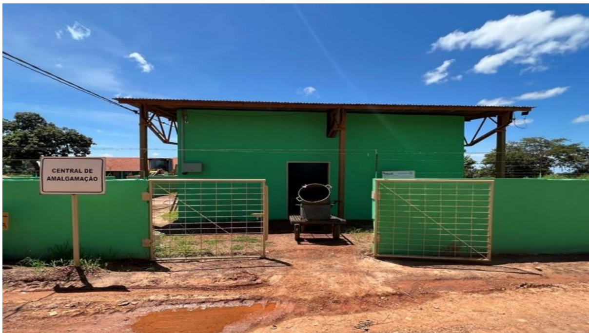
Figura 76. Central de amalgamação
